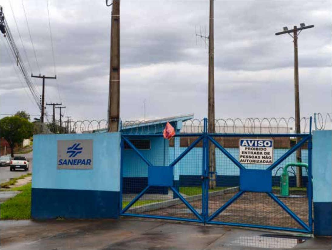
Poço artesiano localizado na Avenida 13 de Maio, esquina com a Rua Osvaldo Barizon, em Nova Esperança. A estrutura integra a rede de produção de água utilizada no abastecimento do município
