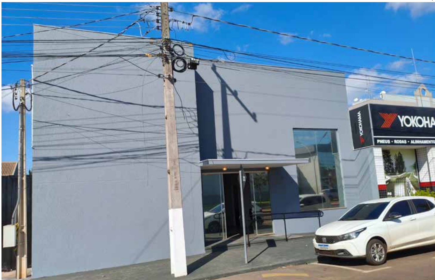
Nova sede da 25ª Delegacia Regional de Polícia de Nova Esperança recebeu adequações estruturais e será inaugurada no próximo dia 11, ampliando a capacidade de atendimento à população e as condições de trabalho da Polícia Civil
