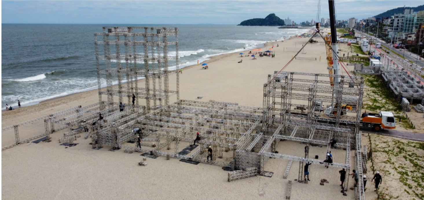
Estruturas estão sendo montadas em Matinhos e Pontal do Paraná para os shows do Verão Maior Paraná
